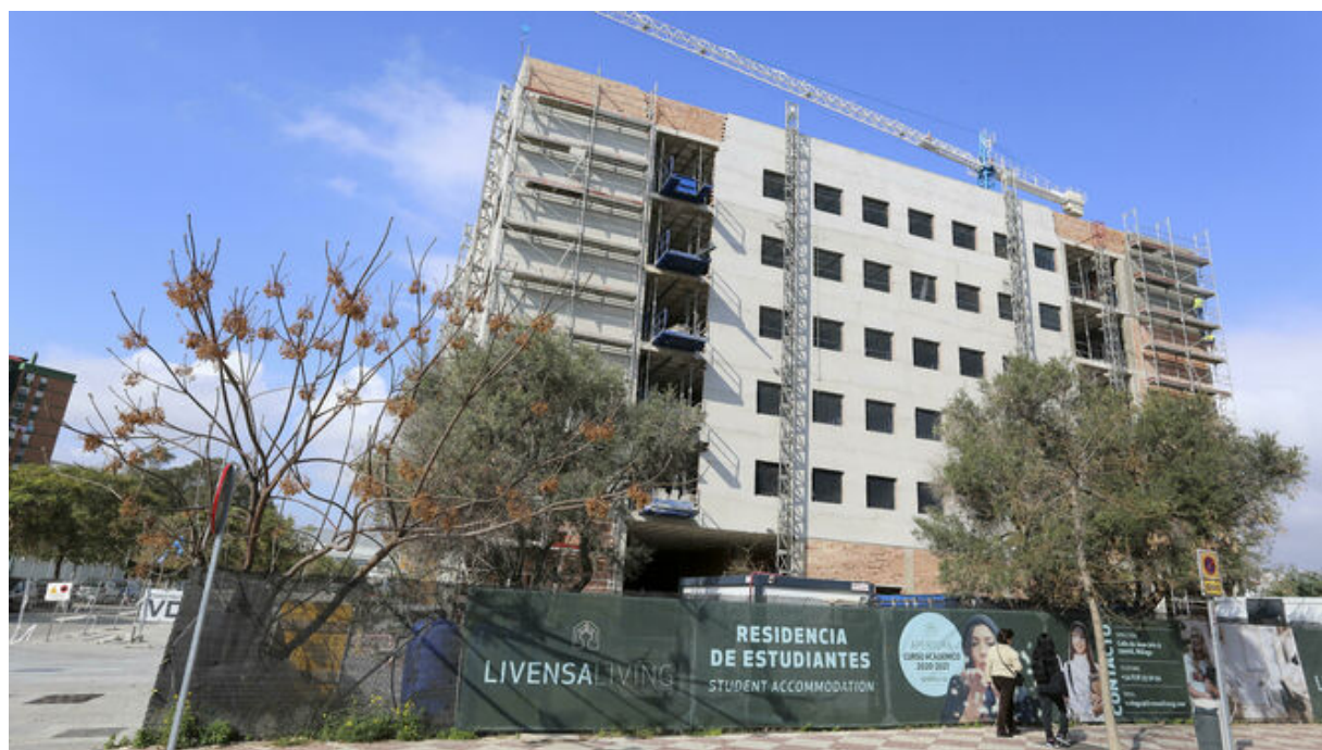
Construcción de la residencia de estudiantes en la calle Juan Gris. / JAVIER ALBIÑANA
