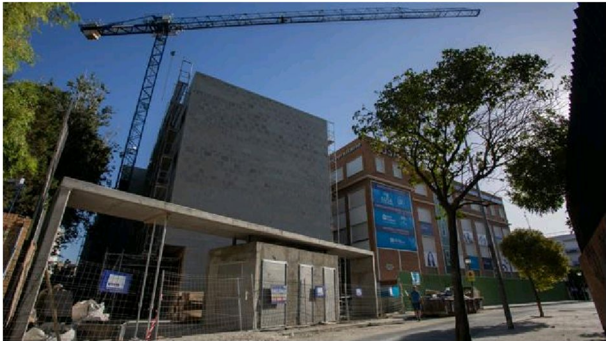
Obra de la residencia del campus de Eusa en El Porvenir - Vanessa Gómez
