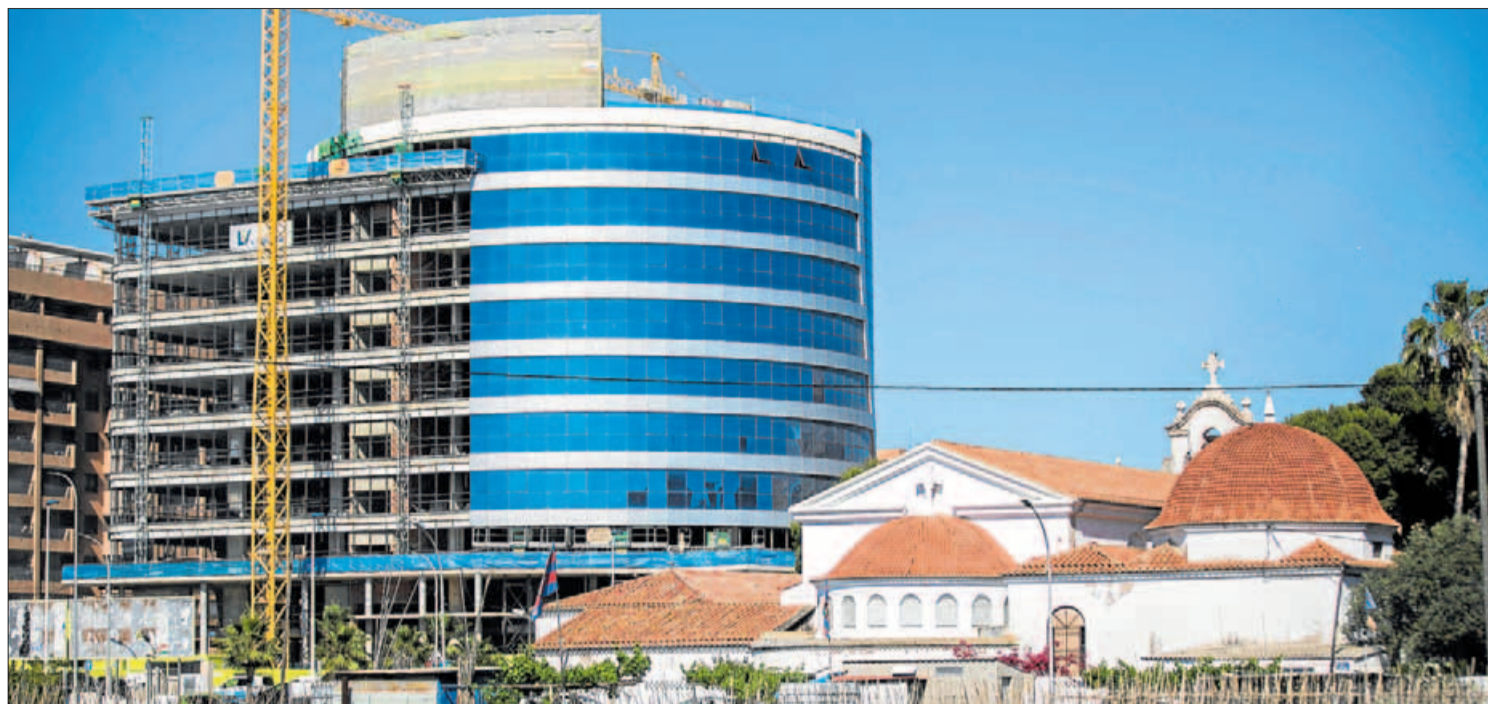
El edificio de ocho alturas abandonado desde hace quince años en la Patacona, en Alboraiá. GERMÁN CABALLERO
